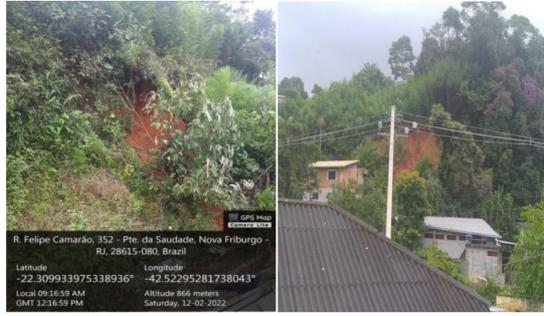
Escorregamento do tipo planar em solo siltoargiloso, comprometendo infraestrutura de abastecimento elétrico, colocando em risco imóveis e via pública.
